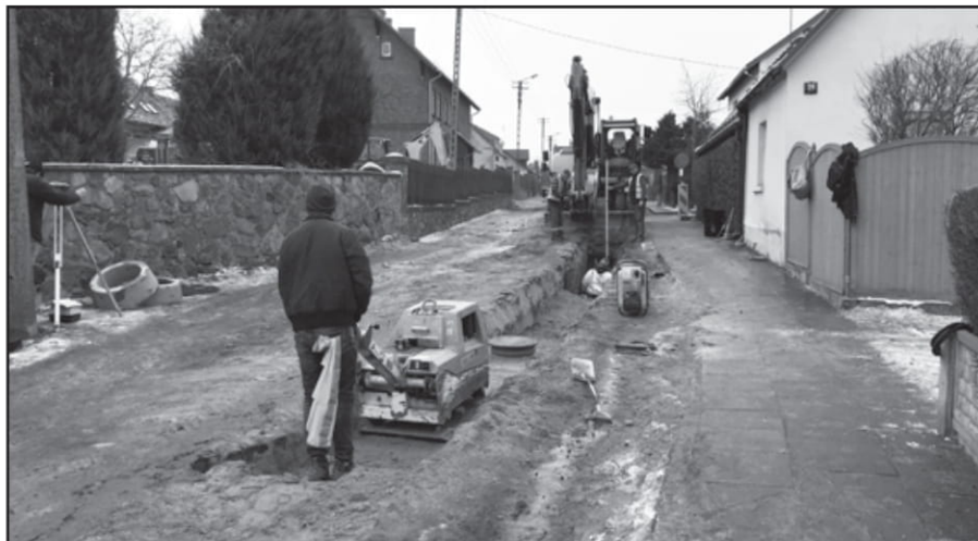
Na projektowanie, budowę i modernizację kanalizacji sanitarnej na terenie gminy wydano w zeszłym roku 4.254.653,00 zł. Na zdjęciu budowa kanalizacji w Dłużynie
